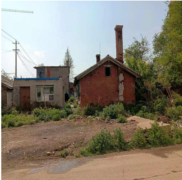
项目西侧(宾西巷)
